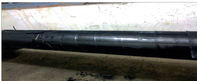
Рис. 3. Зовнішній вигляд покриття на трубі діаметром 325 мм.
